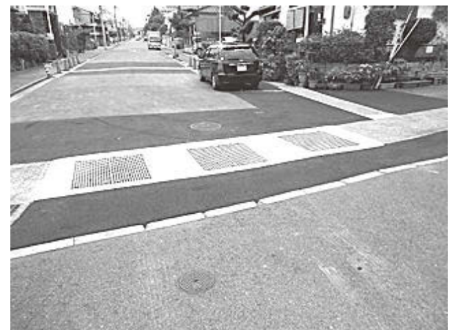
ゲリラ豪雨対策ー側溝を新設 緊急措置で設備されたこの側溝により、昨年夏の府南部豪雨災害時の大雨でも威力を発揮、住宅浸水を防止しました。（宇治市開町）
